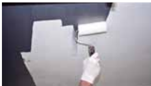
Applicera bottenfärg över grundfärg eller häftgrund
