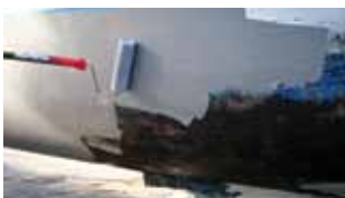
Applicera Underwater Primer på den förbehandlade ytan
