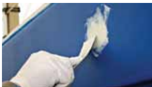
Punktspackla med kittkniv eller smalspackel
