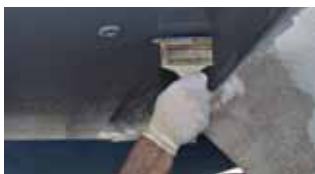
Eftersläta High Protect i andra riktningen med pensel
